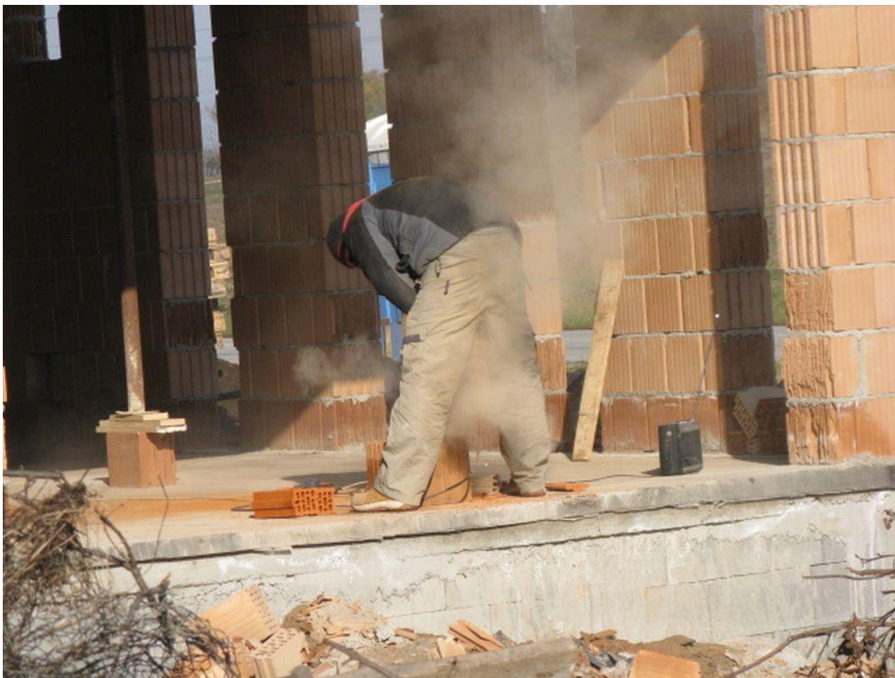
Tégla vágása flexszel, légzésvédelem nélkül.
